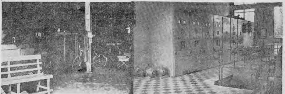
Un aspecto interior de las instalaciones de la Planta de Puntarenas. De un lado lo que había cuando el ICE compra el Sistema, y del otro, los modernos tableros de control.
